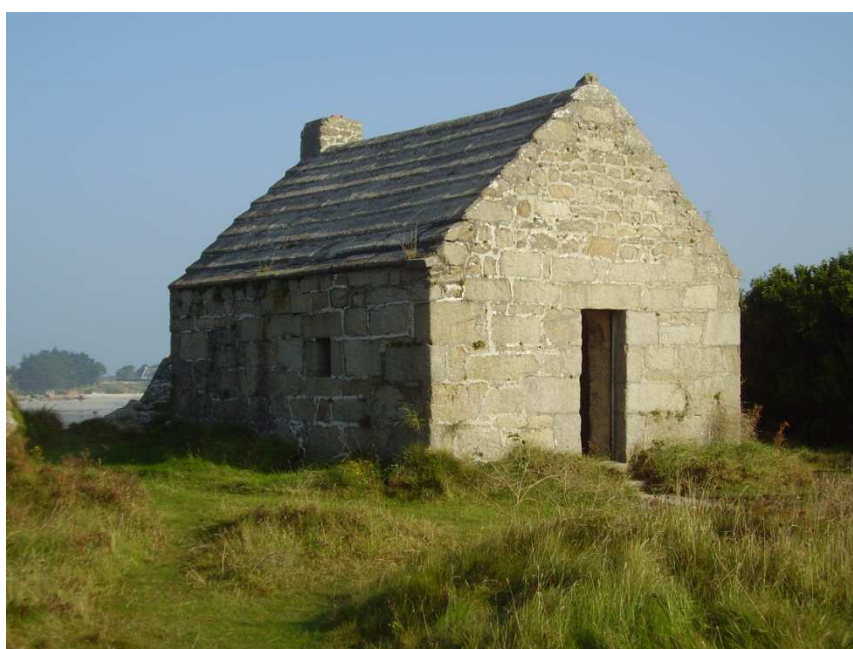
Figure 2. Exemple de corps de garde
